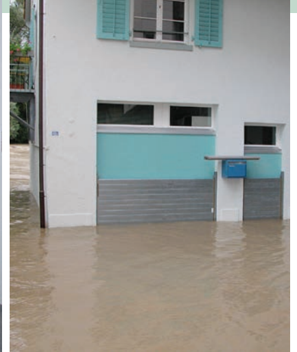
August 2007 – Im Schweizer Kanton Aargau tritt die Reuss über die Ufer. WP WASTO verhindert den Wassereinbruch in das Gebäude. Die Räume hinter dem Stahlsystem bleiben trocken und sauber.
